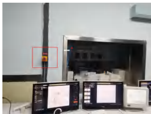
操作室紧急紧急止动开关
